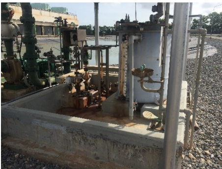
Concrete Curbing และ Floor Drain ของสารเคมีปรับสภาพ น้ำ HRSG Blowdown
