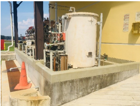
Concrete Curbing และ Floor Drain ของระบบผลิตน้ำ ชุดที่ 2
