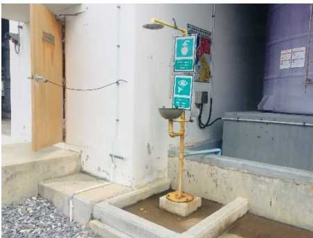
Concrete Curbing และ Floor Drain ของสารเคมีปรับสภาพ น้ำ HRSG Blowdown
